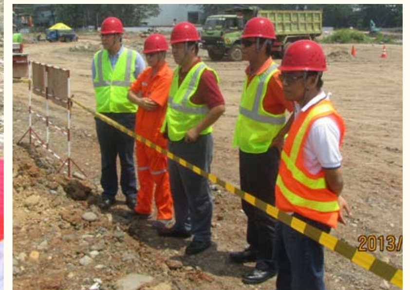
石稳龙前往施工现场视察
