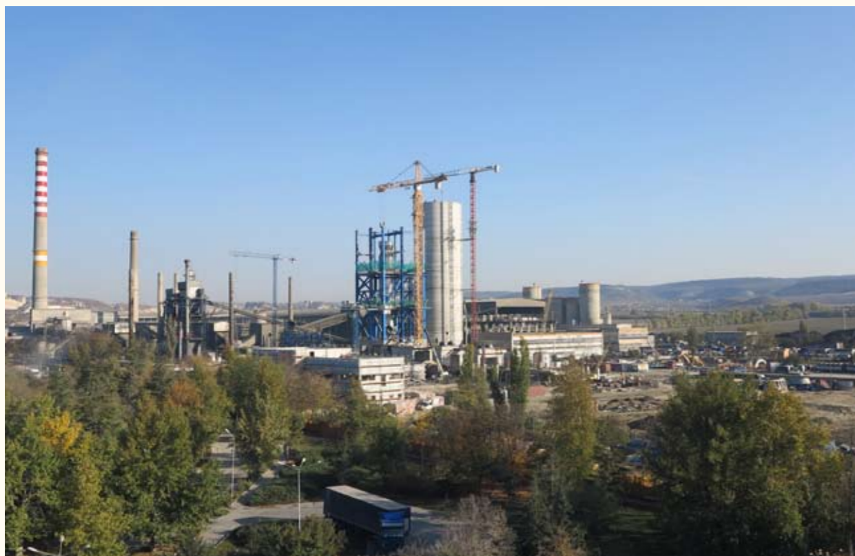
公司正在建设的保加利亚Devnya项目
